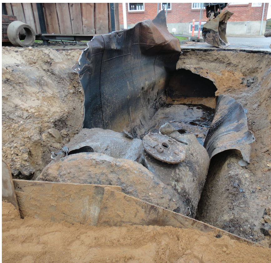
Foto viser opgravningen af en større olietank.
