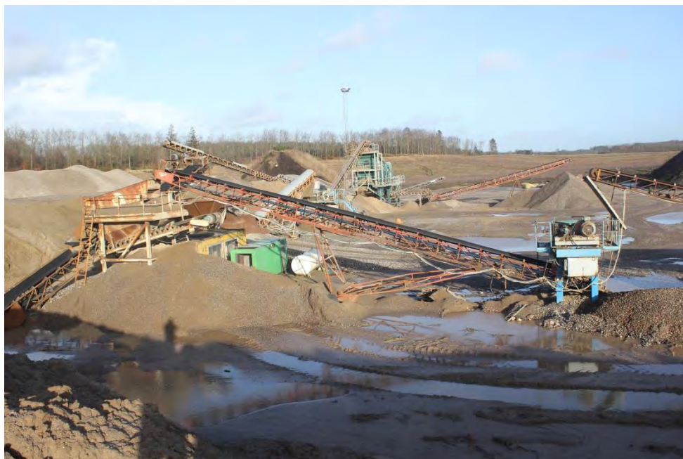
Figur 3.12: Produktionslinjen til stabilgrus. Længst til højre ses forknuseren, og forrest til venstre ses det midterste sortéranlæg med dieseltank og generator ved siden af. Centralt ses det stationære sortéranlæg, og mellem de to sortéranlæg kan endnu en knuser anes.
