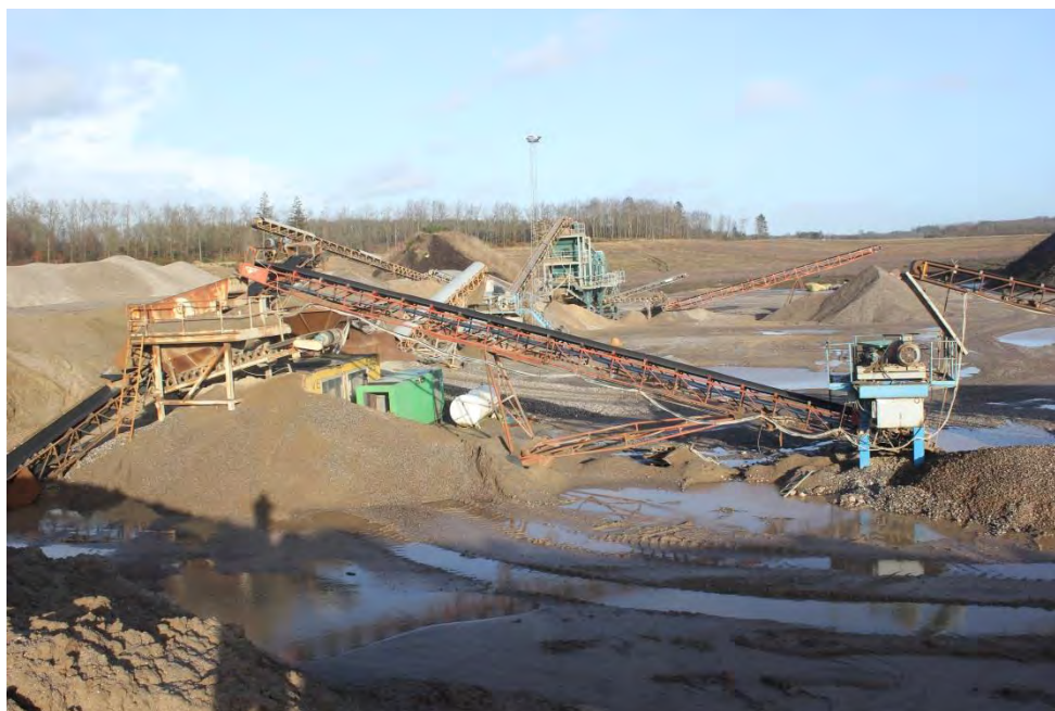
Figur 4.13: Produktionslinjen til stabilgrus. Længst til højre ses forknuseren, og forrest til venstre ses det midterste sortéranlæg med dieseltank og generator ved siden af. Centralt ses det stationære sortéranlæg, og mellem de to sortéranlæg kan endnu en knuser anes.
