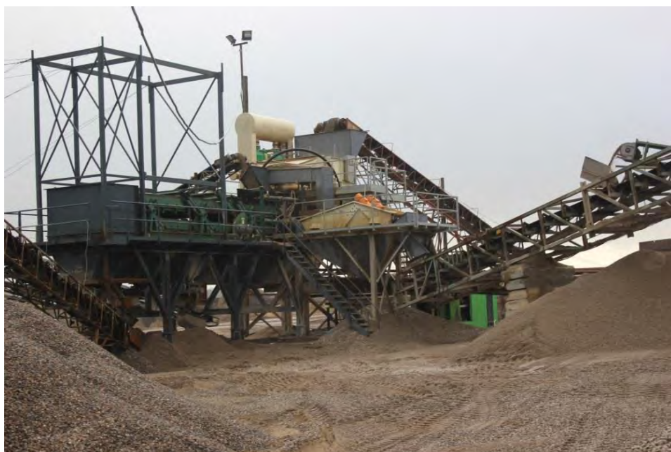
Figur 4.9: Densitetssorteren, jiggen, der ved vibrationer sorterer materialet efter vægt. Densitetssorteren er en del af anlægget til betontilslag.
