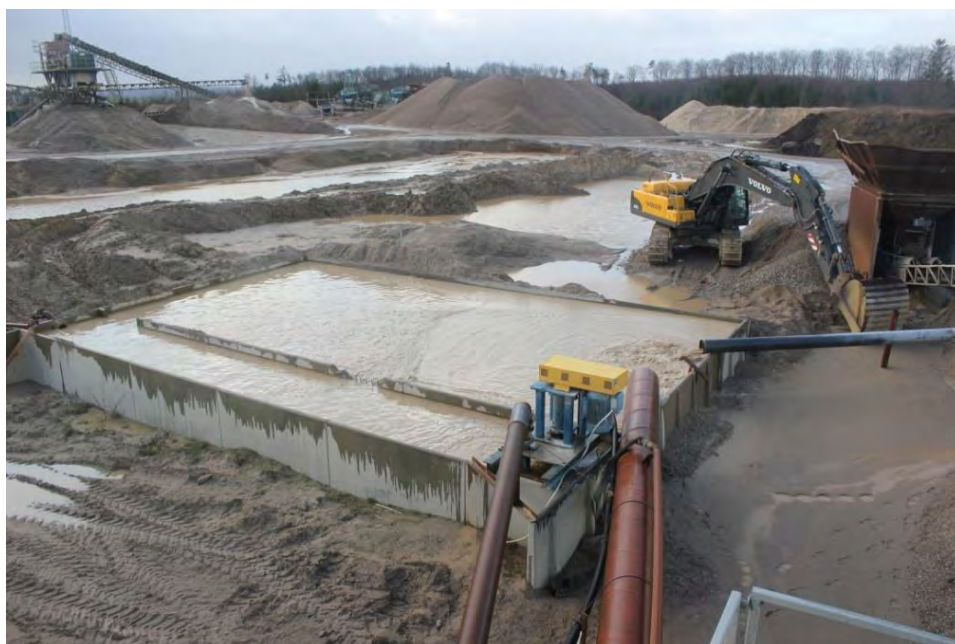
Figur 4.10: Slambassin ved anlægget til betontilslag, hvor vandet fra densitetssorteren og sorteringsanlægget ledes hen.
