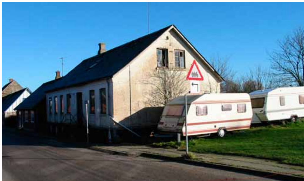
Der er huse i Hørdum, hvor nedrivning bør overvejes
