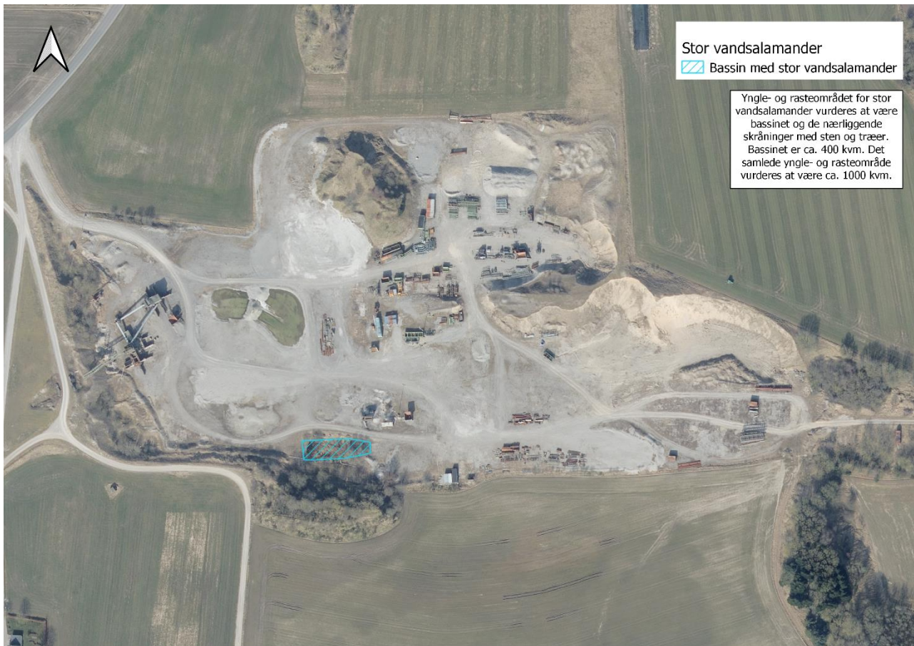
Figur 1: Oversigtskort over råstofgraven. Bassinet hvor der er fundet stor vandsalamander er markeret med blå skravering.
