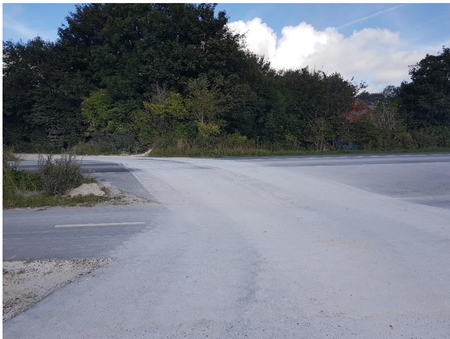
Foto der viser overkørsel på Ballerumvej set fra øst mod vest.
