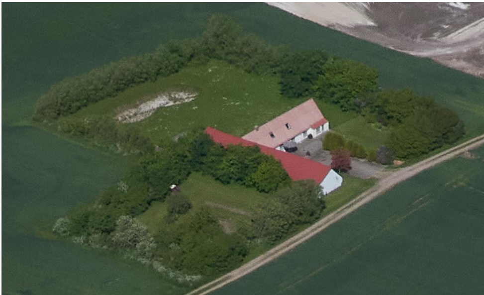
Figur 6: Ejendom der skal nedrives
