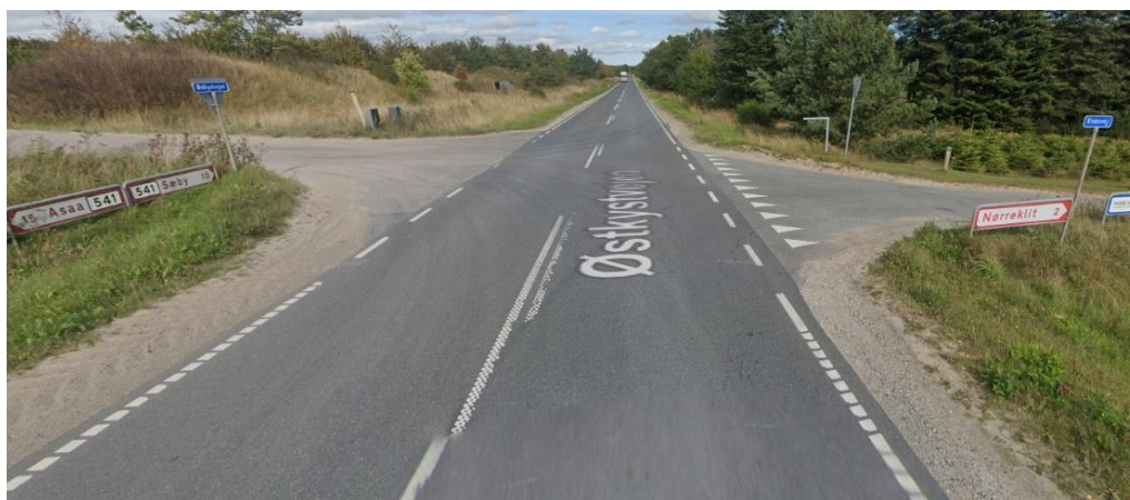
Figur 8-2: Krydset Østkystvejen/Knøsvej. Billedet er taget syd for krydset i nordgående retning. Kilde: Google Maps, 2022.
