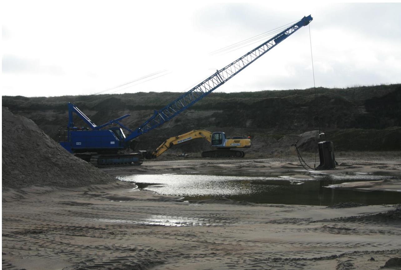
Figur 3-12 Hydraulisk gravemaskine (gul) og wiremaskine (blå) til indvinding ca. 4-5 meter under grundvandsspejl til der er tilstrækkelig med vanddybde til sugeprammen.
