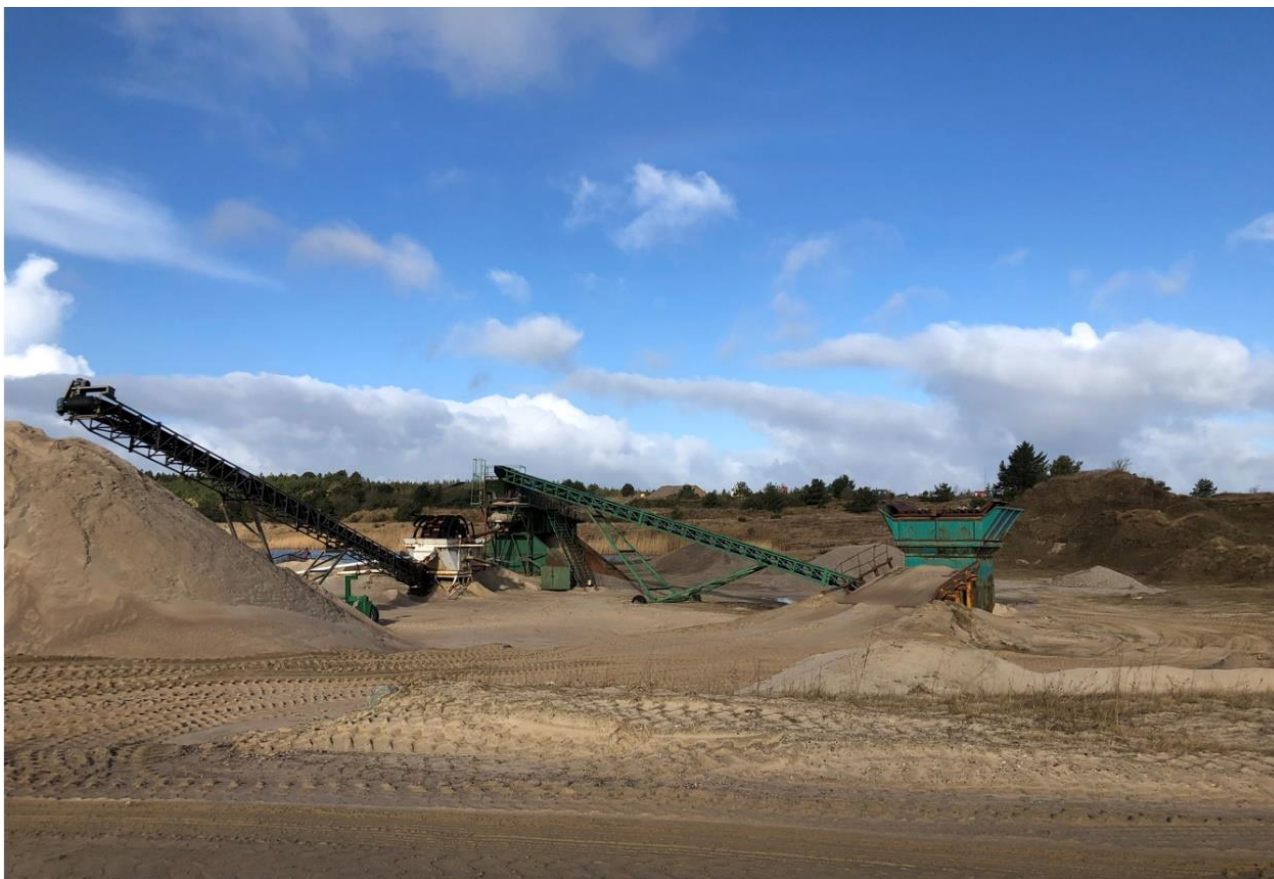
Figur 3-10 Vådsorteringsanlæg – vaskeværk med rundsorterer til venstre i billedet.
