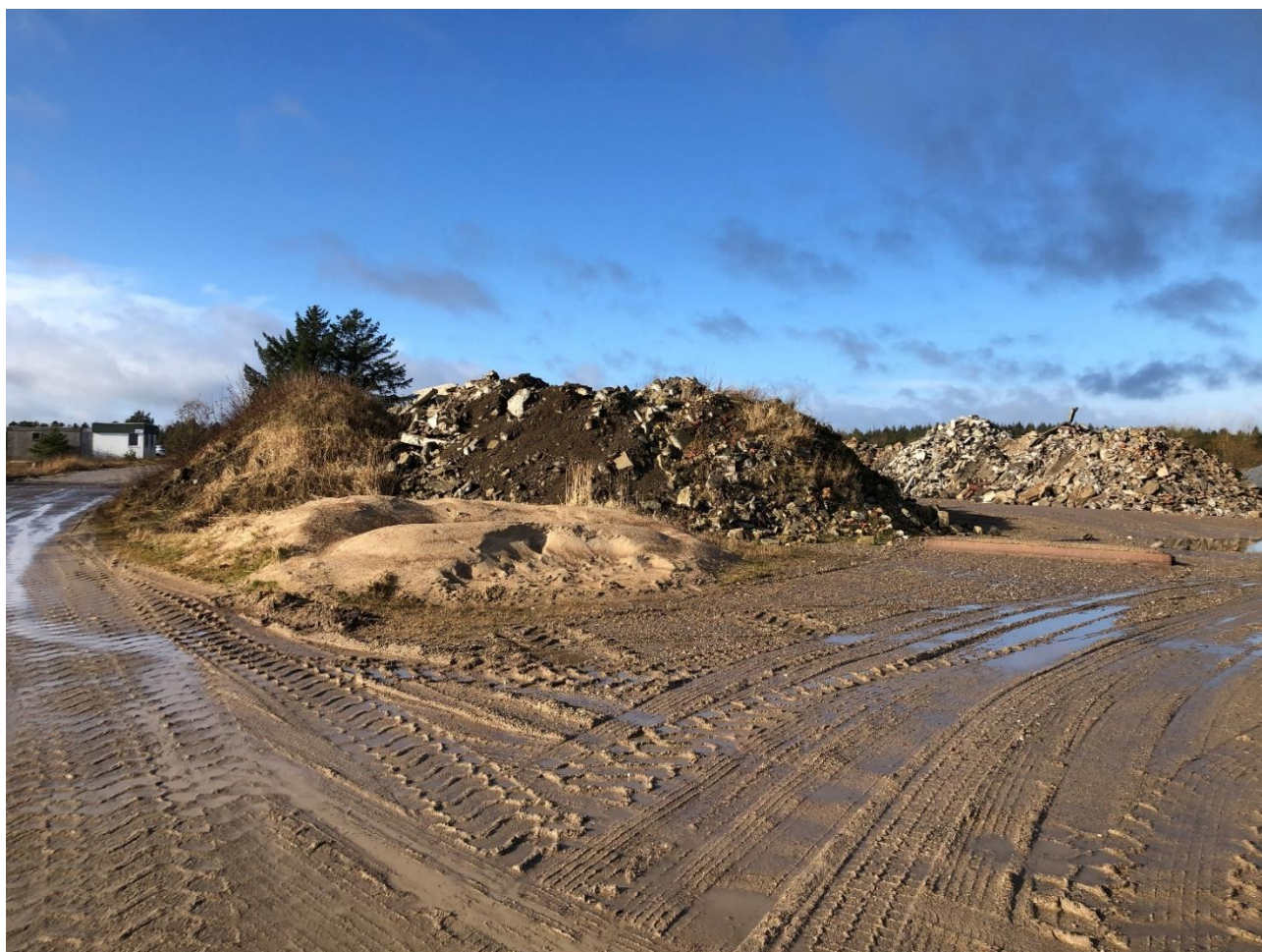
Figur 3-7 Indkørsel til grusgraven. Længst væk ser mandskabsvogn, og nærmest ses genbrugsplads til knusning af beton til genbrug.
