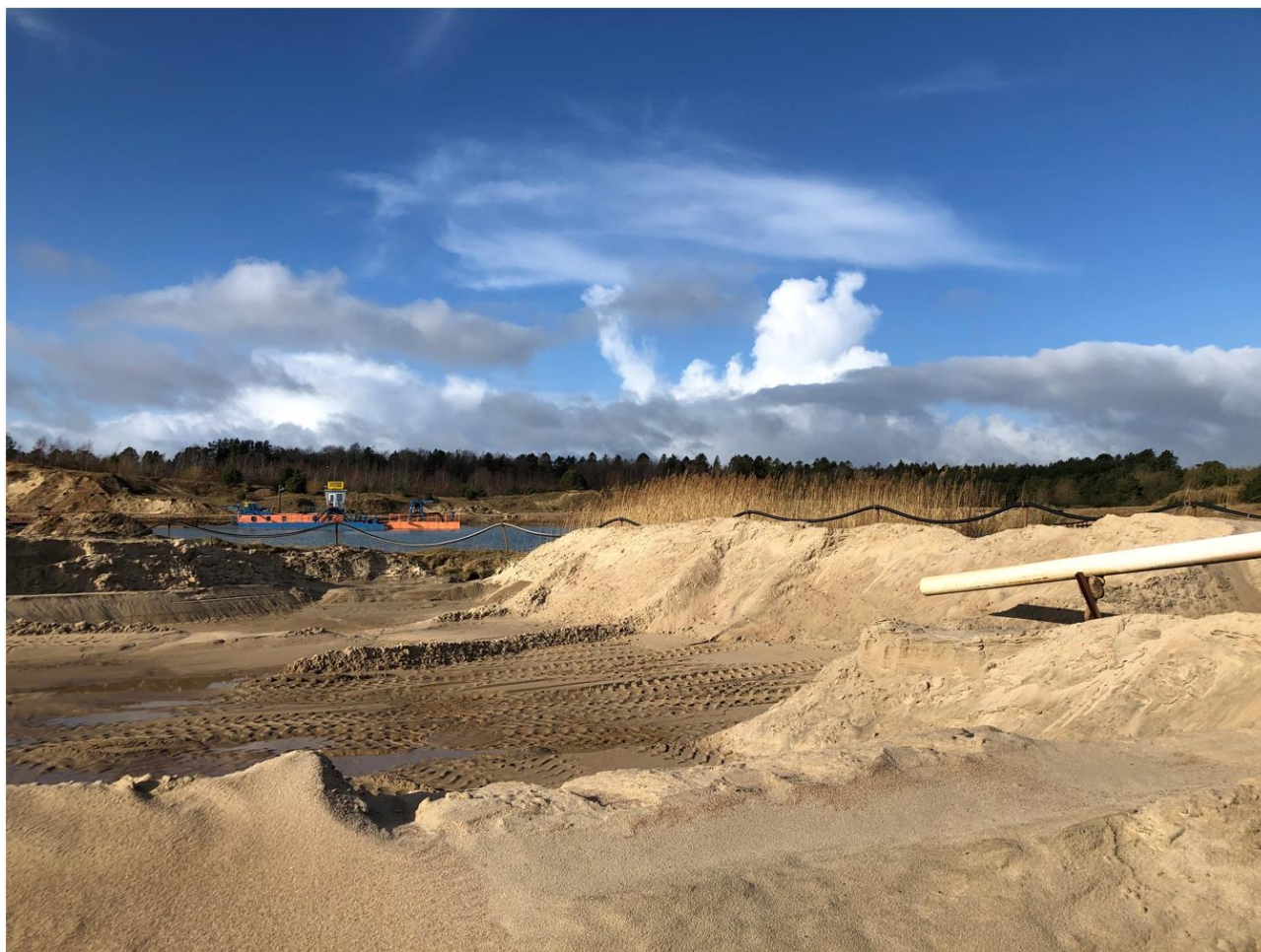
Figur 3-11 I forbindelse med vådsorteringsanlægget ledes vaskevand med ler og silt retur til vaskesøen via et sedimentationsbassin, der har et overløb videre ud i gravesøen.
