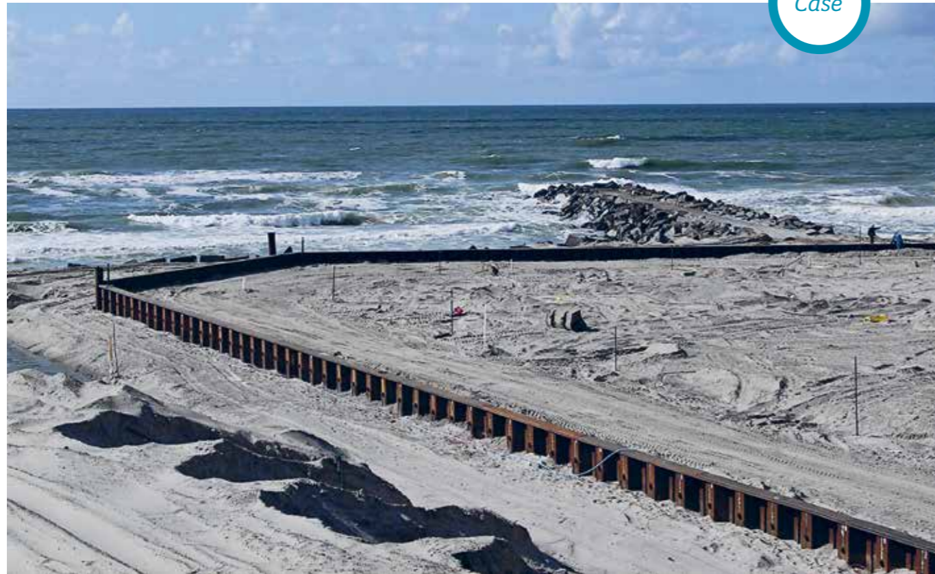
August 2006, depotet ved Høfde 42 bliver indkapslet med en jernspuns.
