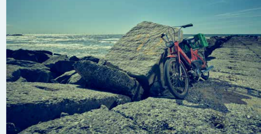
Kemikaliedepotet ved Høfde 42. Området er dækket med sand, og en jernvæg i jorden sikrer, at giften ikke siver ud i havet.
