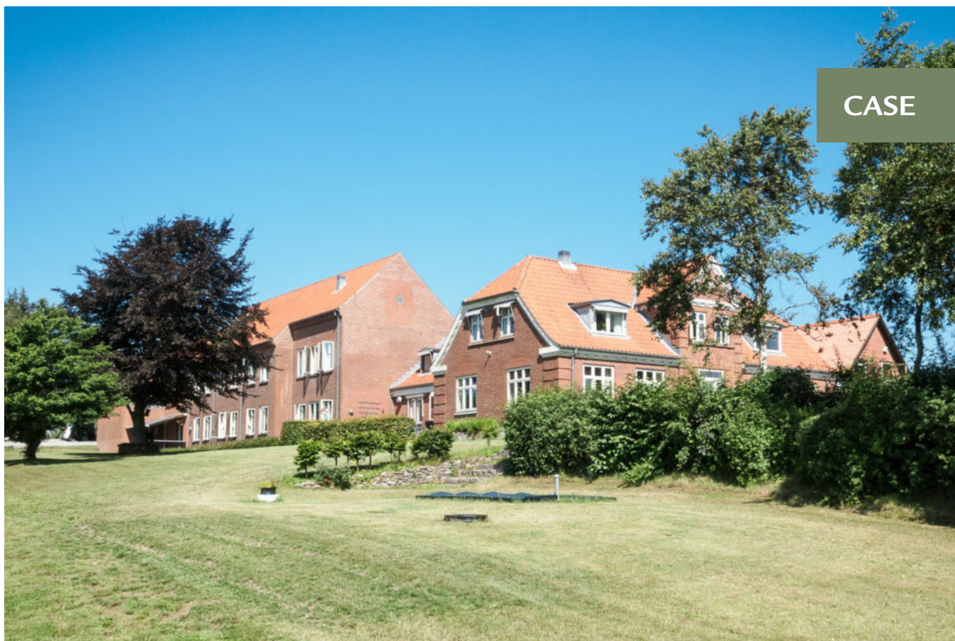
Foto: Med en ny luft til vand varmepumpe har de grønne omgivelser ved Forsorgshjemmet Aas fået følgeskab af en grønnere og mere miljøvenlig varmekilde.
