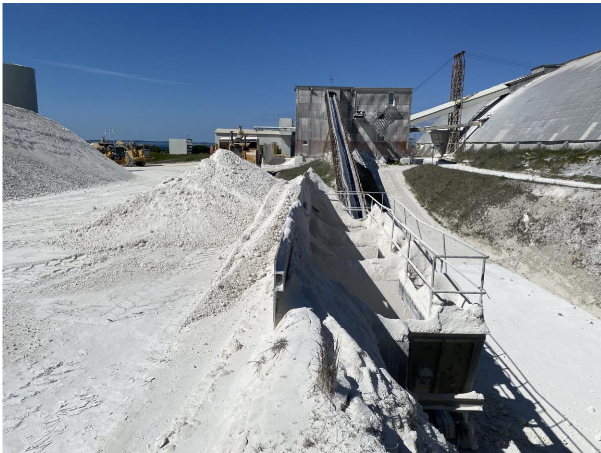
Figur 2-6 Nedgravet fødekasse med transportbånd til fabrikken i baggrunden.
