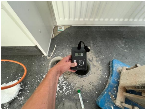
#5 Efter hultagning i etagedæk, er prøver B, C og D udtaget i åbningen – her fugtmåles på in-situ støbt betondæk.
