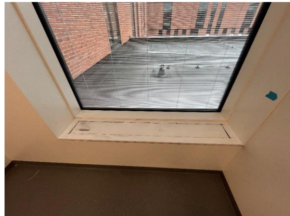
#10 Hultagning igennem nederste aluminiumslysning.
