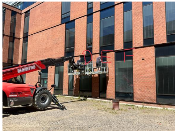
#2 D02. Prøver MY6-MY10 er udtaget fra sider og bund på inddækning efter demontering af blindfelt
